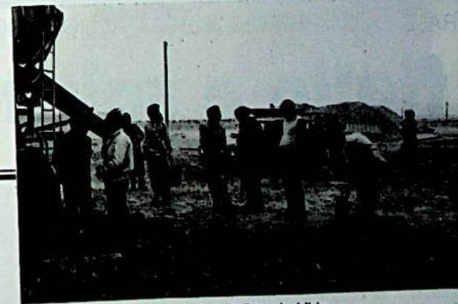
Tecnici e operai in un cantiere italiano in Libia
