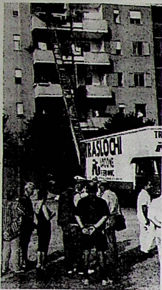
Il palazzo Iacp di via Trigno verrà presto abbattuto
