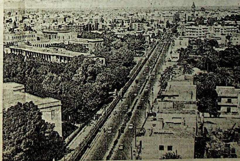
La strada principale di Tripoli, che conduce alla piazza delle Poste (sulle sfondo, verso il mare, il campanile e la cupola della cattedrale). E' questa una foto «proibita»: un anno fa, in primavera, sono state ritirate dalla circolazione tutte le cartoline con paesaggi e anche foto di singoli edifici. Si vendono solo cartoline di fiori, cammelli, tramonti, costumi
