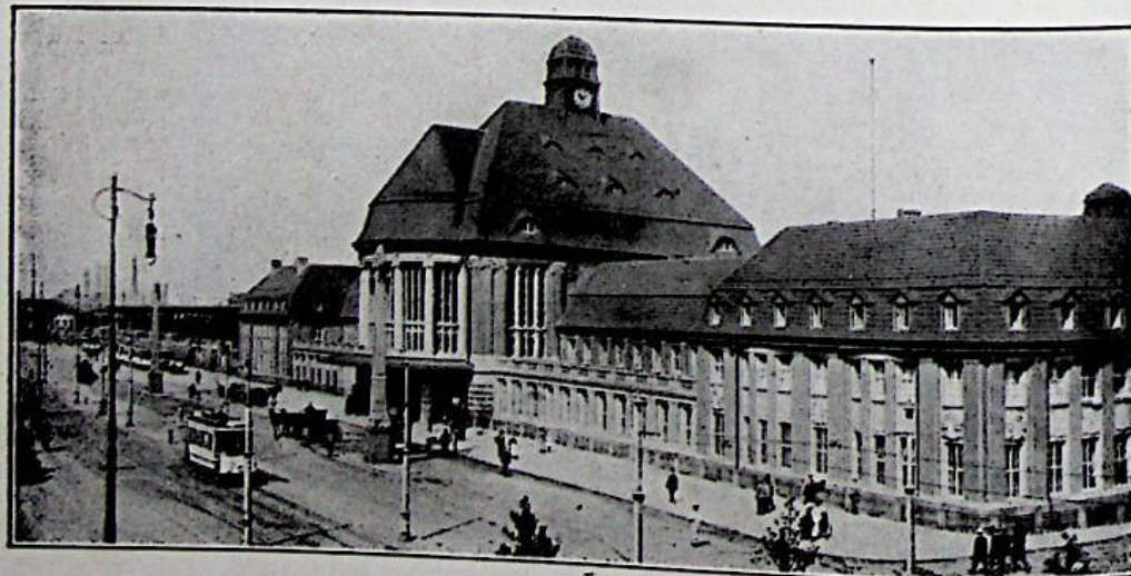
I GANGLI DEL TRAFFICO FERROVIARIO: LA STAZIONE CENTRALE DI DORTMUND.
