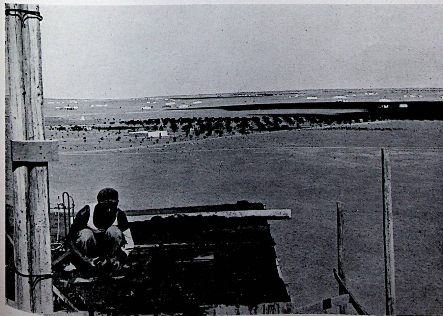
Dal campanile in costruzione del villaggio "Crispi",
