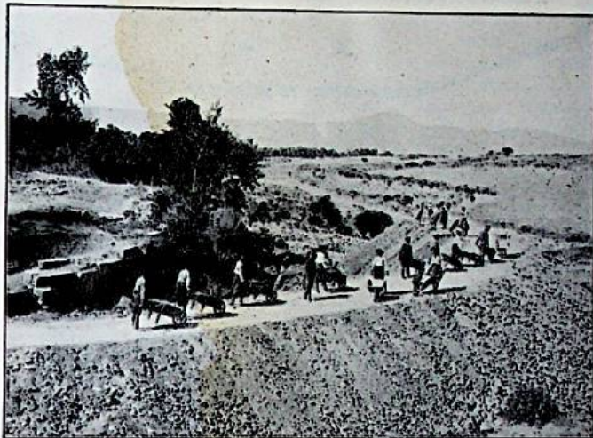
Gortina (Creta) — Lavori per la deviazione del fiume Leteo dall'edifizio della « Grande Iscrizione ».
