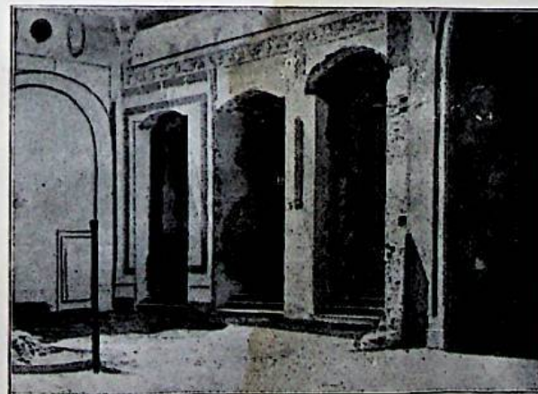
3. Stato dei lavori al momento della demolizione.
